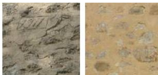
Enduit à pierre vue
