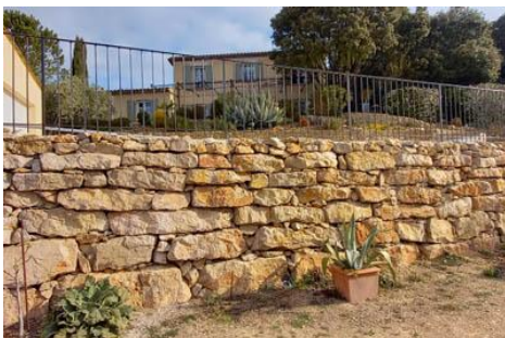
Photo illustrative d'enrochement de moellons de pierre à joints alternés
