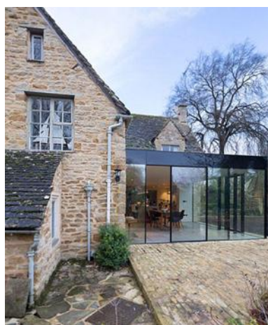
Toiture terrasse sur volume annexe
